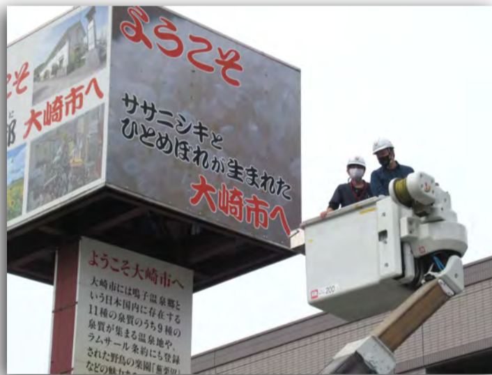
宮城・広告景観タウンミーティングでは高所作業車に乗せていただきました
